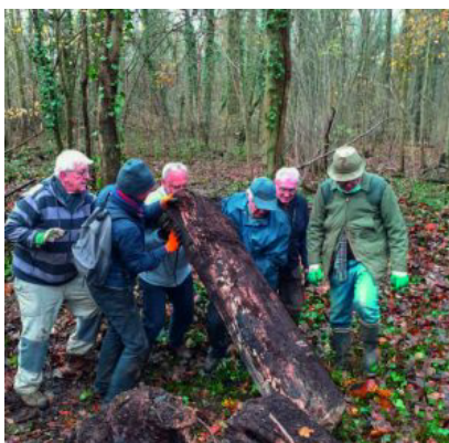
Travail de débroussaillage: les vieux arbres tombés en travers de la rigole sont déplacés © Arhyme
