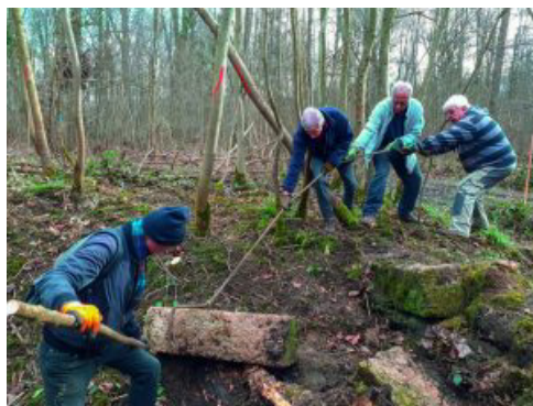
Restauration et remise en place d'une des pierres taillées du dalot n° 2, route du mail © Arhyme
