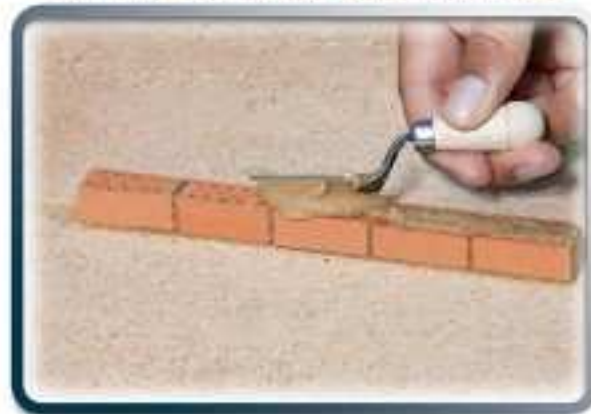
3°) Mise en place du ciment 2/2
