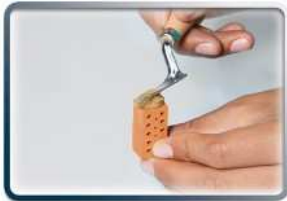
2°) Mise en place du ciment 1/2
