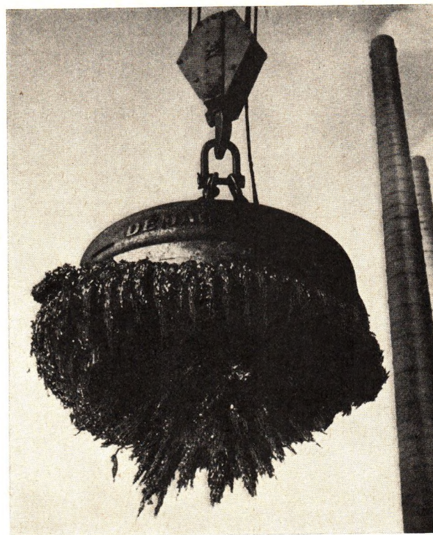
Manutention de ferraille à l'aide d'une grue à électro-aimant
