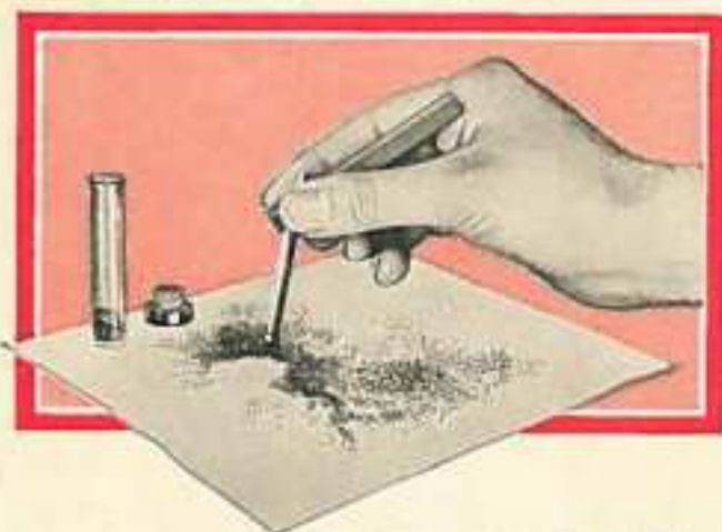
Fig. 7. Moyen pratique de ramasser la limaille éparsée à l'aide d'un clou.
