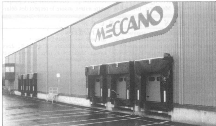
Vue d'ensemble du bâtiment de stockage et d'expéditions.
