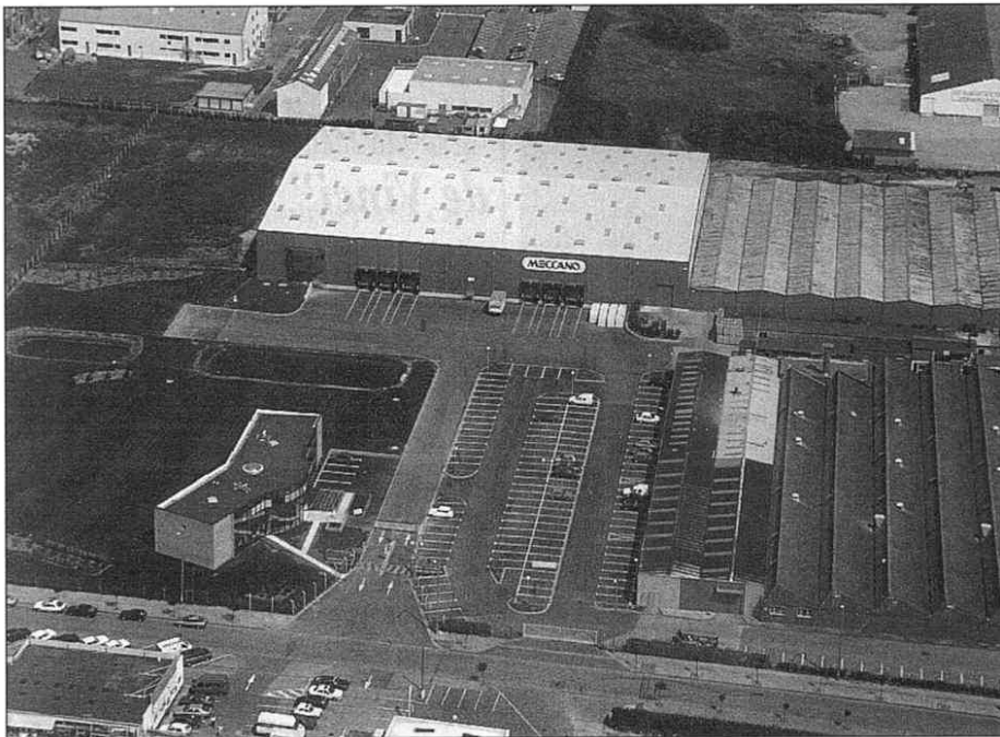
Vue générale de l'usine de Calais en 1995.
