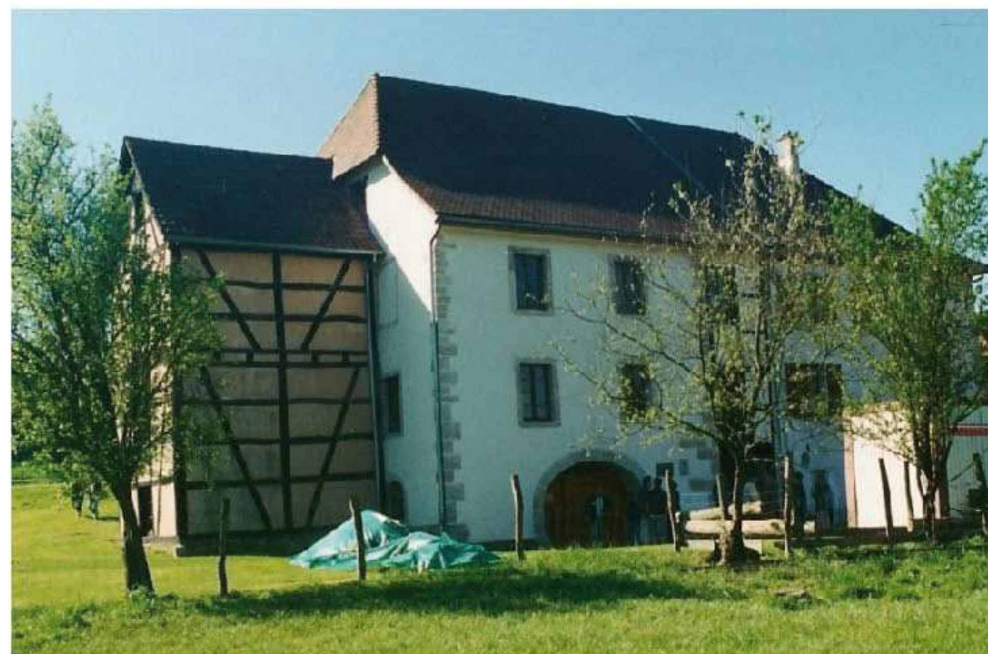
Courtelevant, la façade, la partie droite du bâtiment ne figure pas dans la maquette
