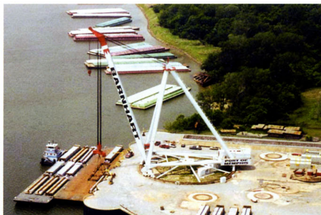
La grue Derrick du port de Memphis (USA)
