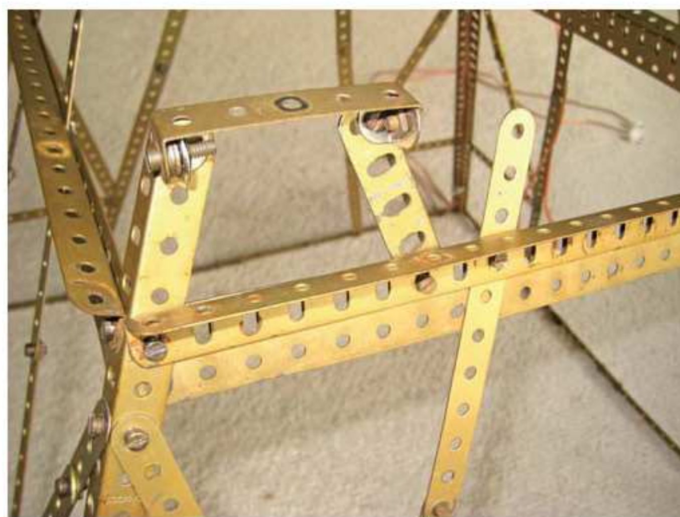
Supports sur la section centrale
