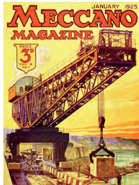
Fig. 1 Une grue pour la pose des blocs de béton
