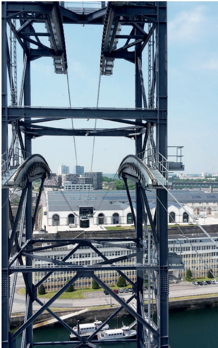
Fig. 4 Passages pour les cabines sur le pylône
