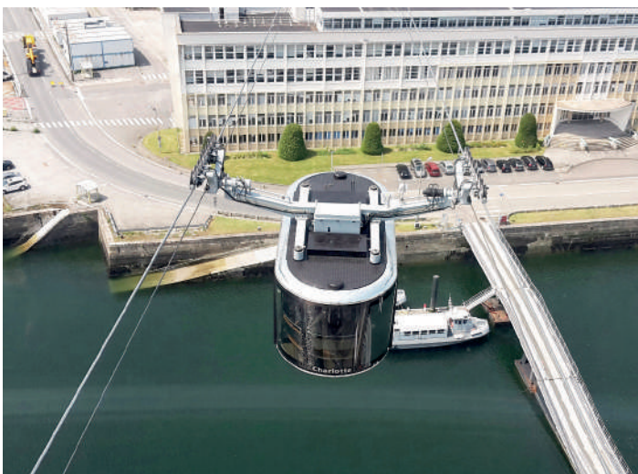
Fig. 2 Cabine basse vue depuis la cabine haute
