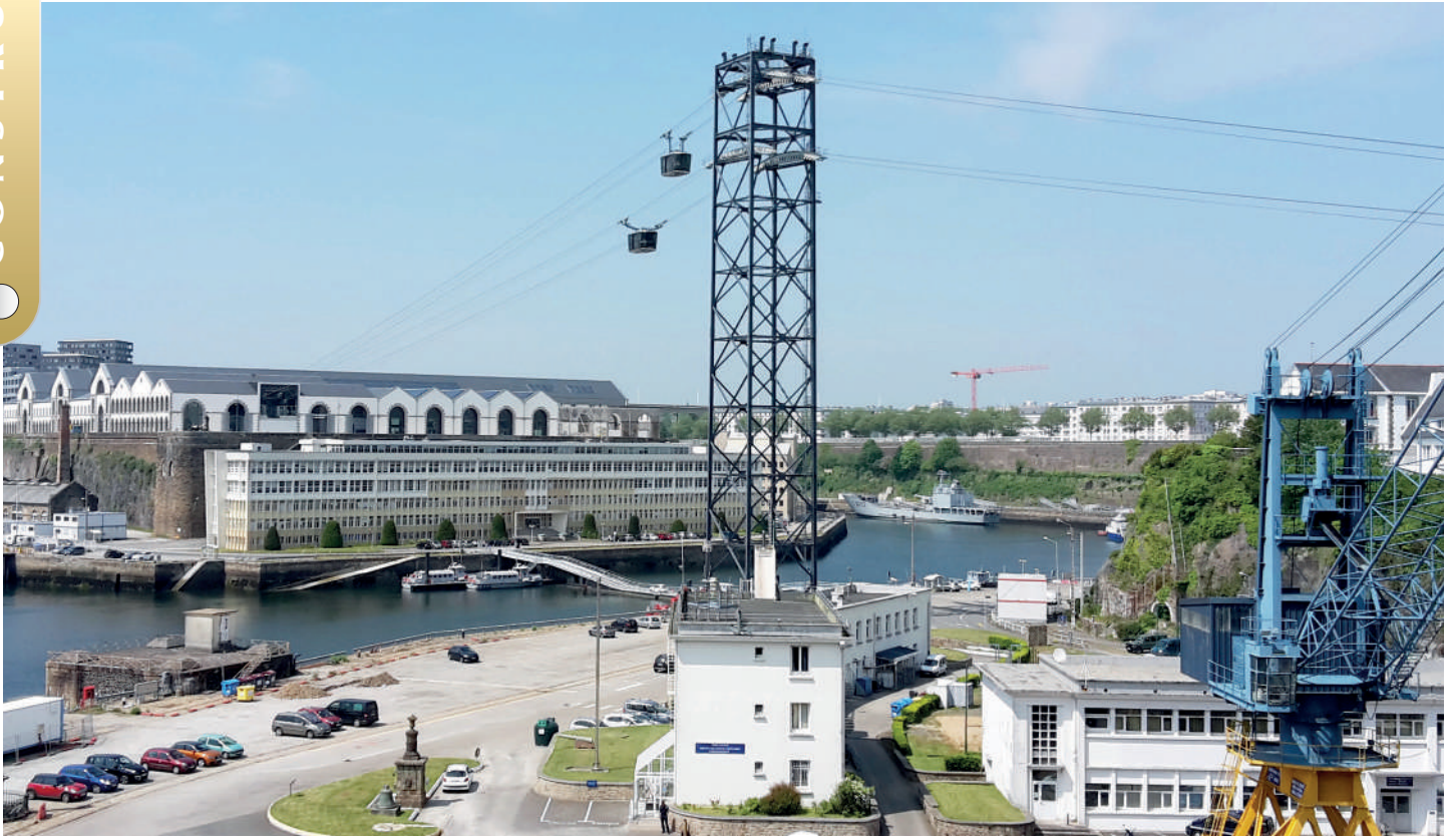
Fig. 1 Vue d'ensemble du téléphérique
