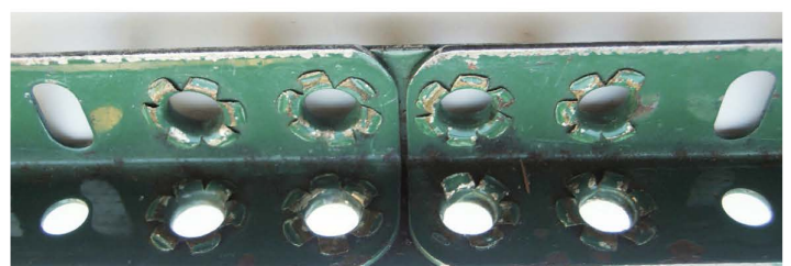
Fig. 4 Gros plan des rivetages, coté intérieur
