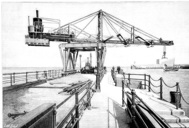
Fig. 1 – La grue Hercules
