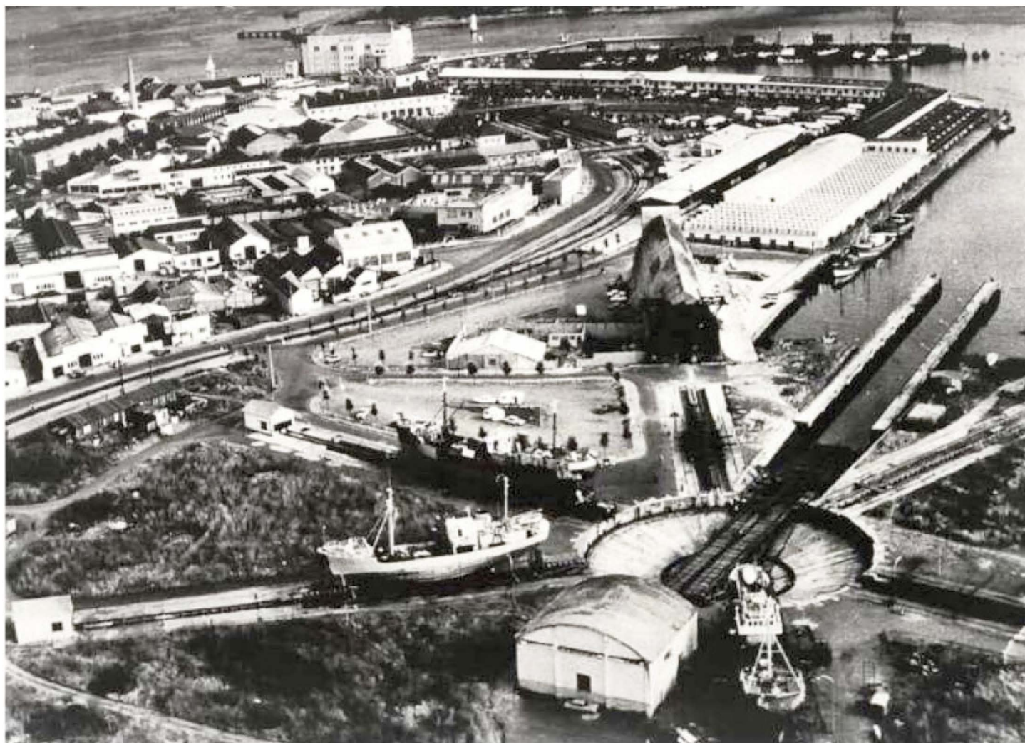
Fig. 1 Le slipway du port de pêche de Lorient en 1965, et les 7 voies de carénage en étoile.
