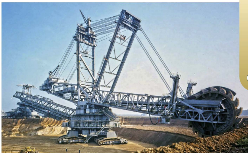
Fig. 1 L'excavatrice à godets Bagger 293
