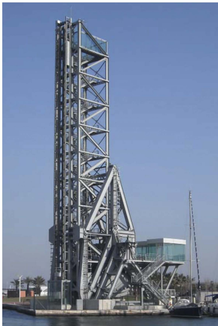
Fig. 1 Le vrai pont levant de La Seyne-sur-Mer Aujourd'hui ouvert au public et inscrit à l'Inventaire Supplémentaire des Monuments Historiques. La grande verrière à l'arrière abrite l'emplacement des mécanismes de manoeuvre. Un ascenseur situé au tablier permet au public à mobilité réduite d'accéder à la plateforme d'observation située à 45 m de hauteur.
