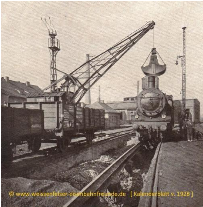
Kohlebagger 1928 mit Drehvogel an der Oberleitung
