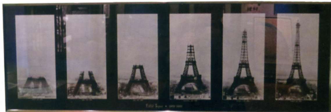
Les différentes phases de construction de la Tour Eiffel (1888-1889)
