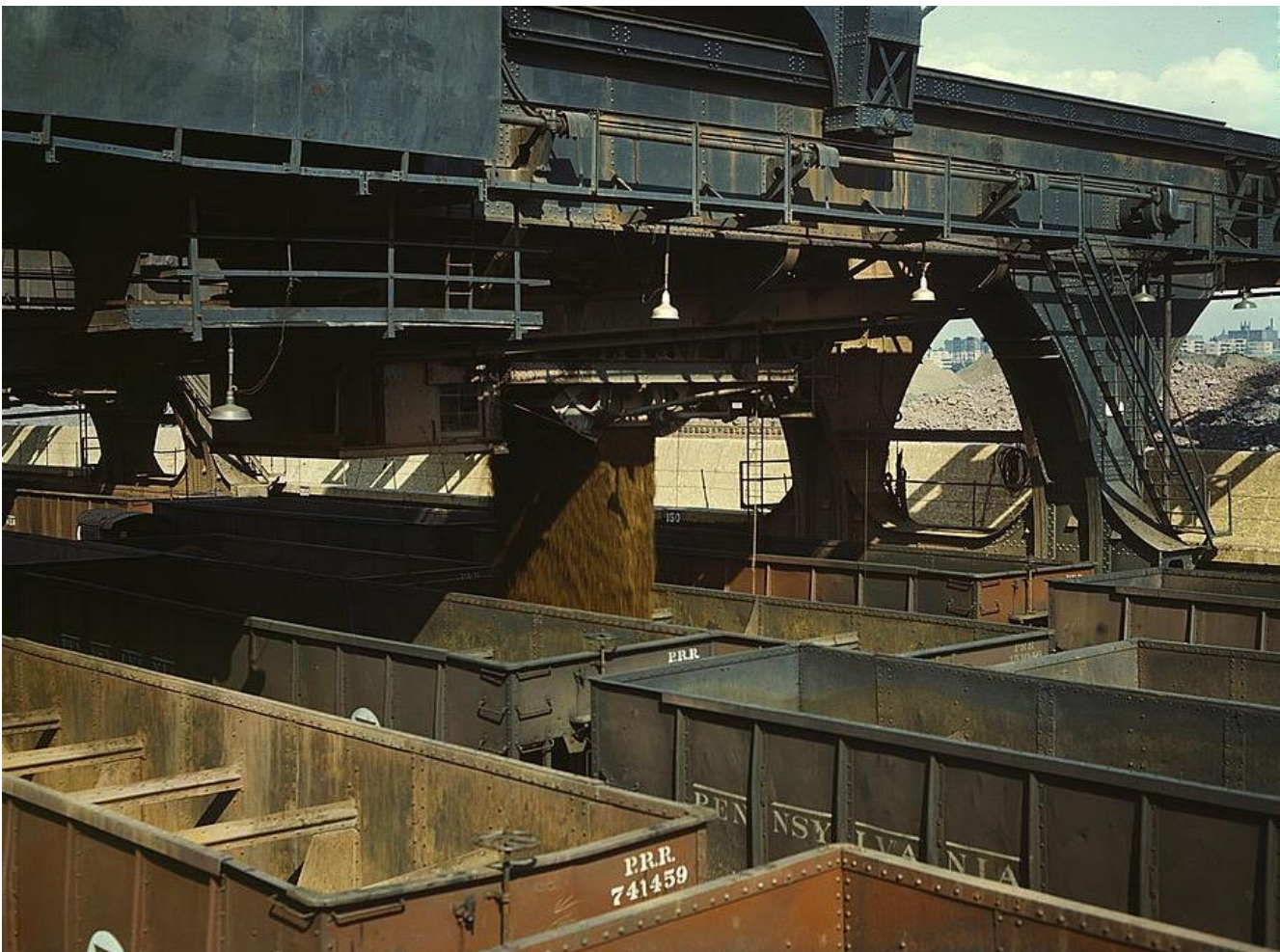
Fig.2: Entladung der Lore in einen Eisenbahnwaggon
