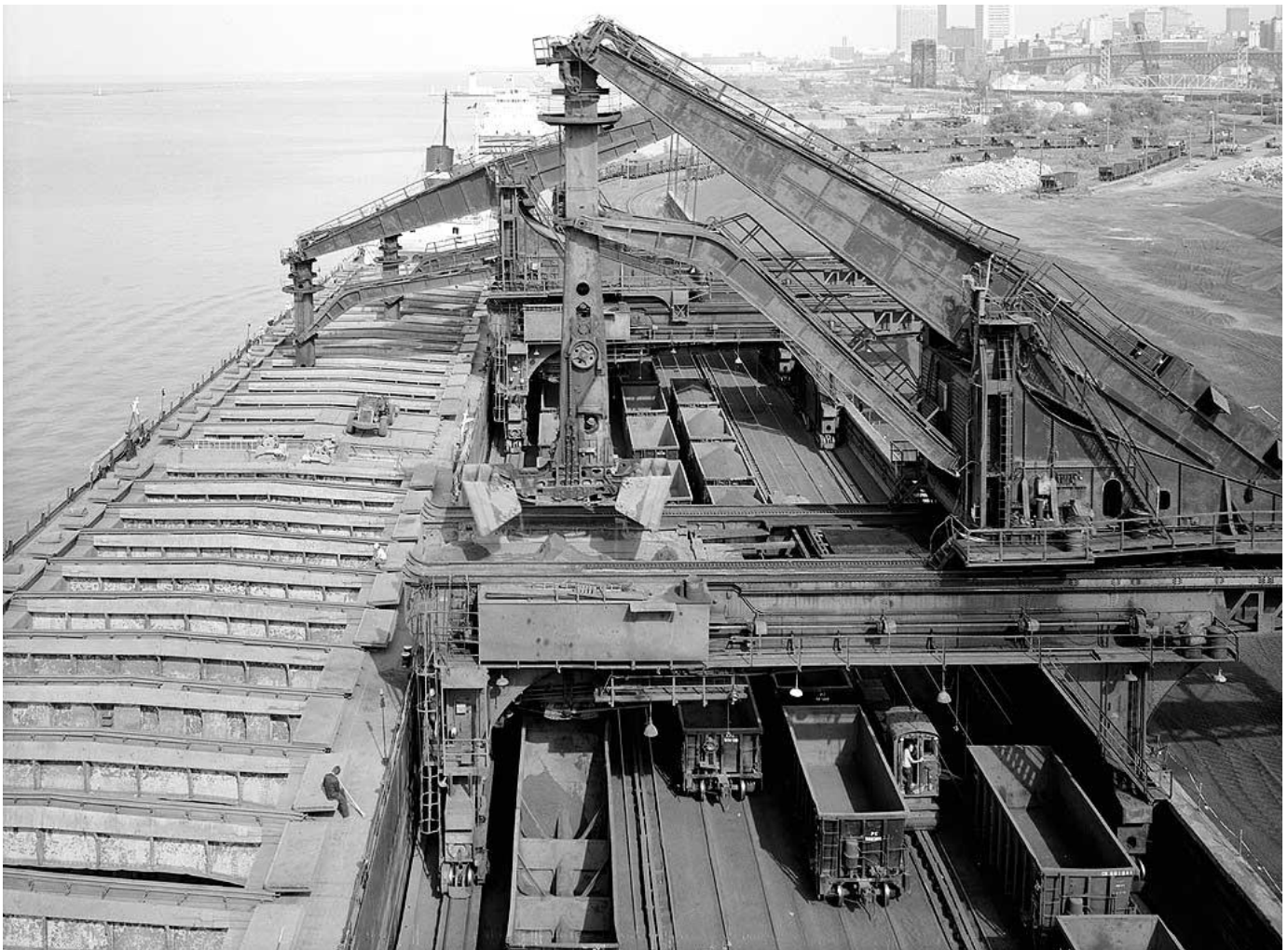
Fig. 1: Hulett Eisenerz-Entladeanlage in Cleveland/Ohio
