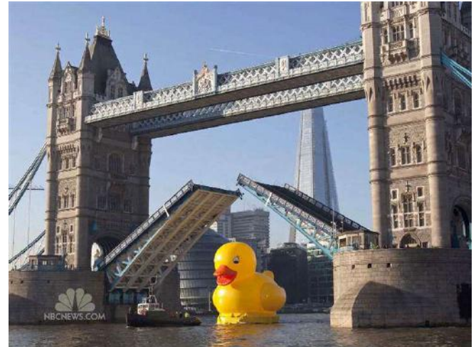
Fig 14 Die Brücke wird nur selten auf Anfrage geöffnet
