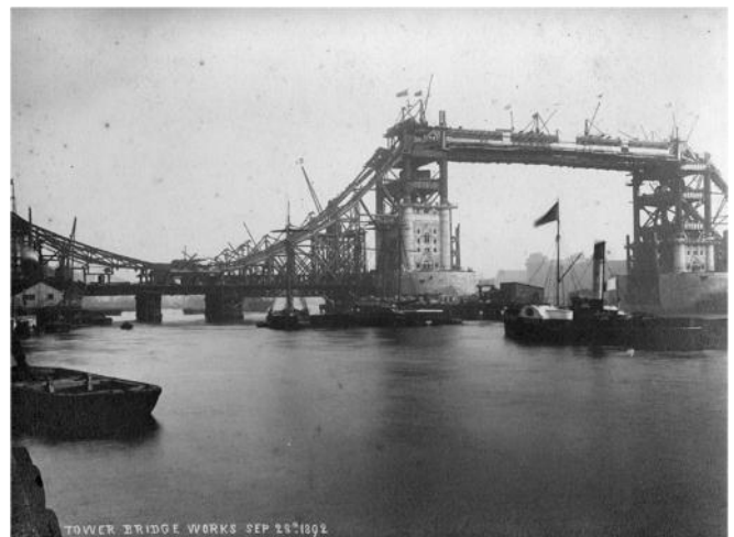
Fig 24 Die Metallstruktur ist fertig, das Mauerwerk kann beginnen
