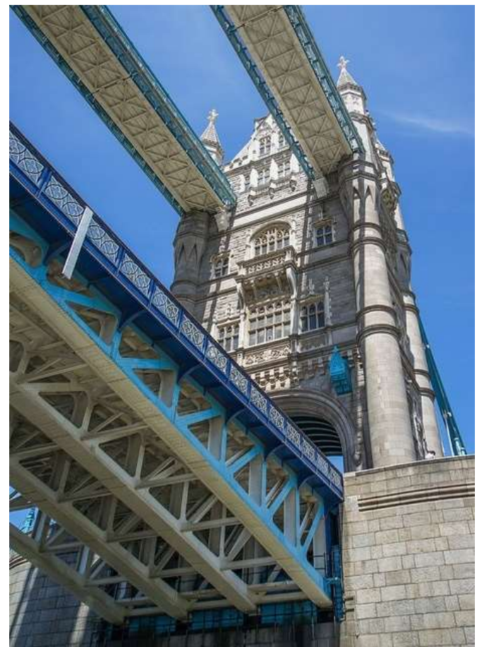
Fig 32 Das hübsche Mauerwerk zeigt unzählige Schmuckelemente
