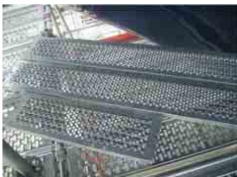
La planche TOUTACIER est résistante, antidérapante, incombustible. Sur la face inférieure sont soudés des goujons équipés de goupilles de sécurité. Ces goujons s'accrochent dans les trous des planchers.
