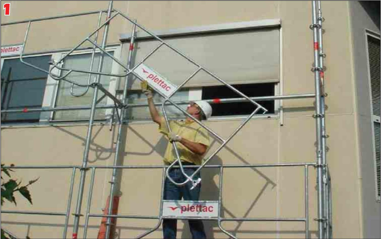
L'échafaudage Métrix comporte des garde-corps permanents de sécurité MDS, montés à partir de l'étage du dessous complètement terminé. Le monteur installe ensuite les planchers du dessus. Il accède alors au nouvel étage en toute sécurité. Le garde corps Métrix est léger, compact, facile à mettre en place.
