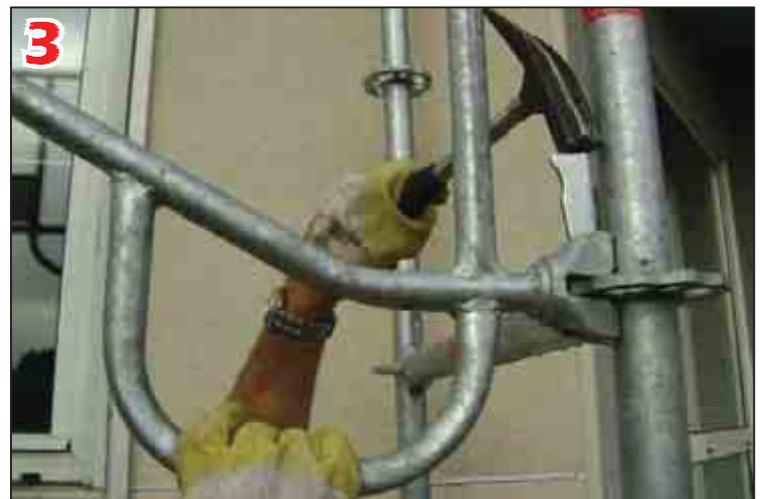
Le garde-corps stabilise la structure. Il permet d'économiser des diagonales dans le cas d'échafaudages de façade uniformément amarrés.
