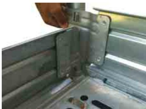
Les plinthes TOUTACIER se bloquent entre les poteaux et les clavettes des lisses. Elles reposent sur les planchers. Existent de 20cm à 3.00m de long.
