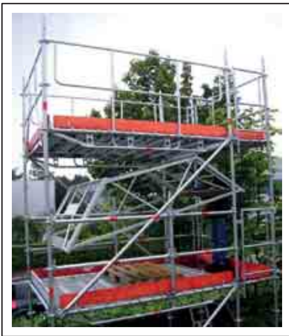
Schéma du garde-corps pour recette de matériaux. Repose sur deux étriers de départ (réf. KETR).
