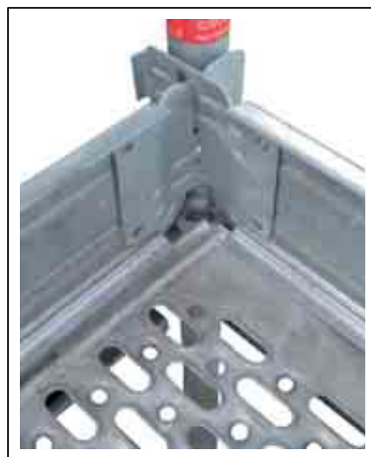
Jonction des plinthes en acier sur deux mailles droites.
