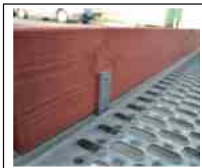
Montage d'une plinthe en bois dans les fentes du plancher.
