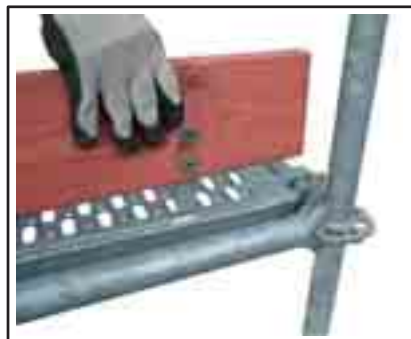
Montage d'une plinthe en bois dans les fentes du plancher.
