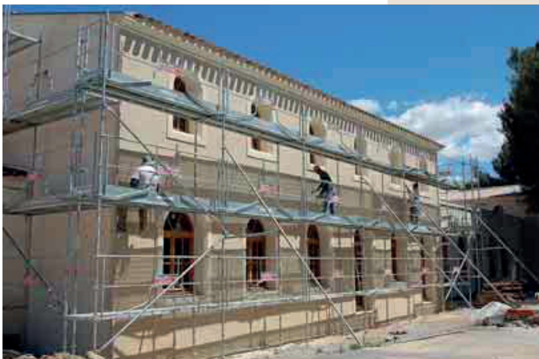
Chantier de façade
