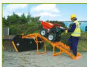
Rampe de déchargement
