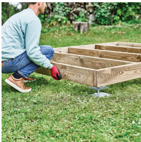
5. Positionner le cadre sur les équerres
