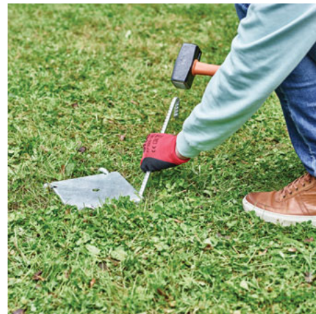
3. Ancrer les embases en plantant les piquets d'ancrage
