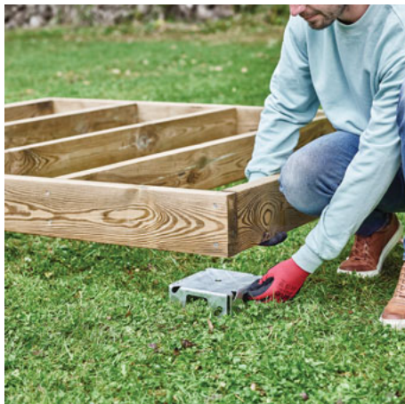
2. Positionner les embases sous le cadre
