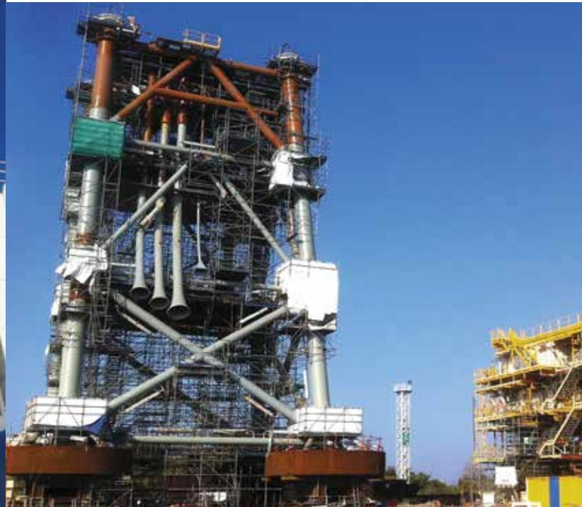
Fos-sur-Mer : échafaudages pour la construction des modules de la plateforme offshore "Anguille".
