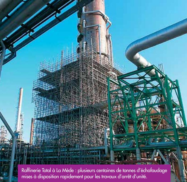
Raffinerie Total à La Mède : plusieurs centaines de tonnes d'échafaudage mises à disposition rapidement pour les travaux d'arrêt d'unité.
