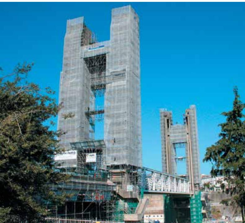
Brest : conception et location des échafaudages et des étaitements pour les travaux de transformation du pont de Recouvrance.
