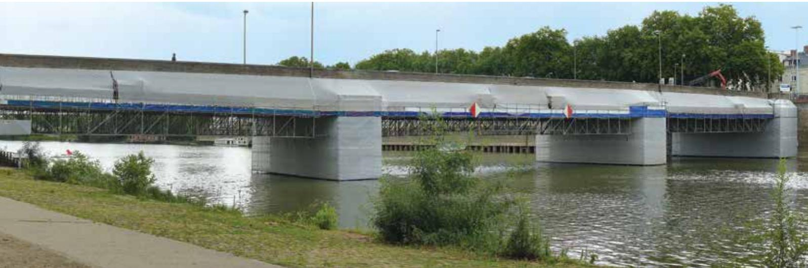
Angers : 1700 m<sup>2</sup> de platelages suspendus pour la rénovation du pont de la Haute Chaîne.
