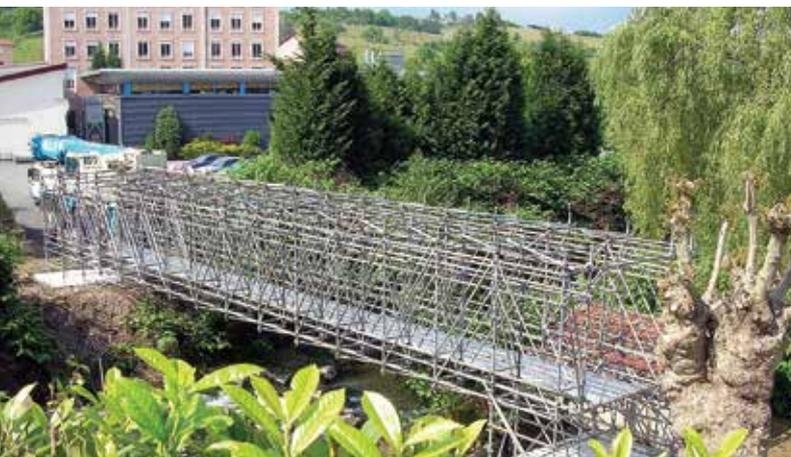
Pont de Courzieu (69) : passerelle pour piétons durant les travaux de rénovation du pont.
