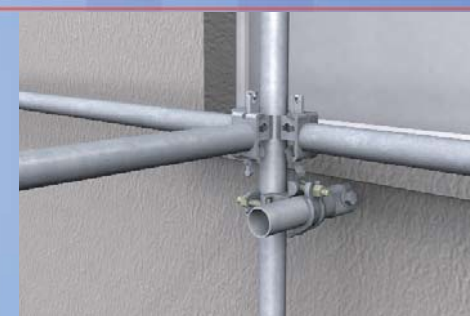
9 - Mise en place des ancrages à l'avancement du montage. Répéter les opérations 6 à 9 jusqu'au dernier niveau.
