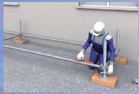
1 - Pose des socles réglables et des départs façades. Mise à niveau des moises.
