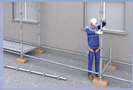
2 - Mise en place des montants de 3,00 m à l'extérieur et des montants de 2,00m côté façade.
