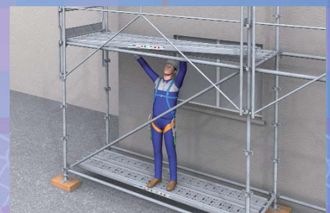
6 - Mise en place depuis le niveau inférieur du plancher dans toutes les mailles du premier étage.
