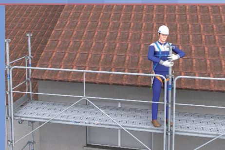
10 - Rehausse du dernier garde-corps pour permettre la fixation du dispositif de protection.
