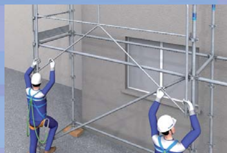
5 - Pose des garde-corps de montage et d'exploitation.
