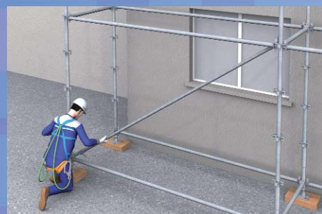
4 - Mise en place des diagonales longitudinales.
