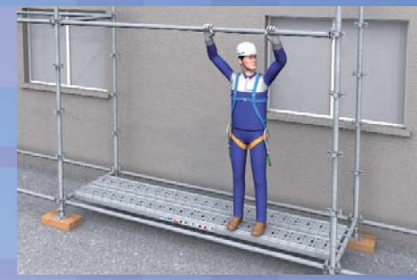
3 - Mise en place des moises à 2,00 m.
