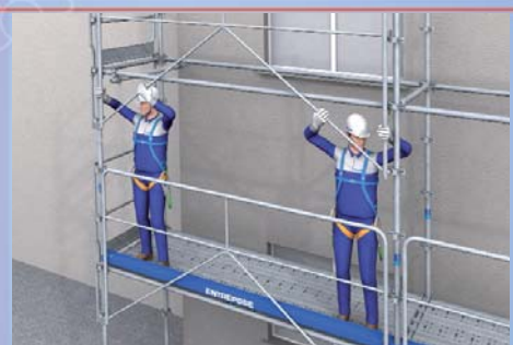
8 - A nouveau, mise en place des garde-corps de montage et d'exploitation depuis le niveau inférieur.
