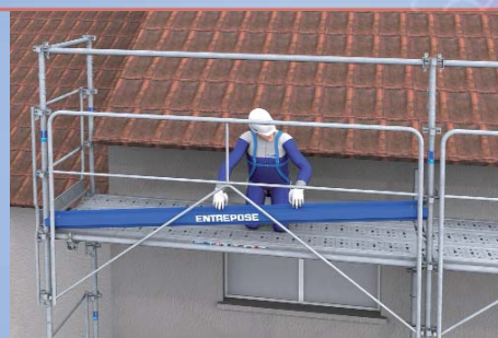
11 - Mise en place des plinthes et des goupilles de jonction des poteaux.
