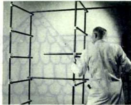
Mise en place des lisses sur les échelles.
