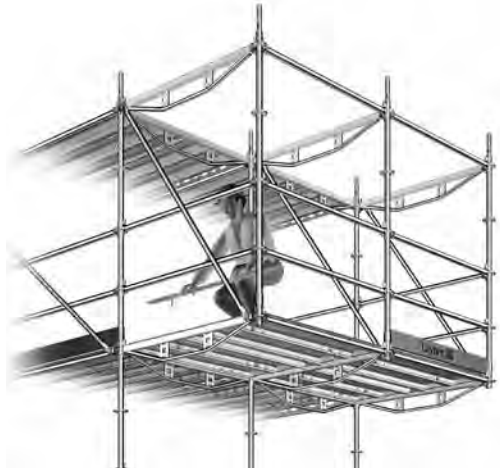
4 Mise en place des joints de sécurité sans aucune intervention sous le plancher réalisé.
