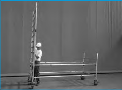
1 - Pose des cadres 4 barreaux sur les galets. Les lisses maintiennent l'ensemble.
