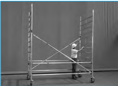
2 - Pose des cadres 8 barreaux puis les diagonales.
