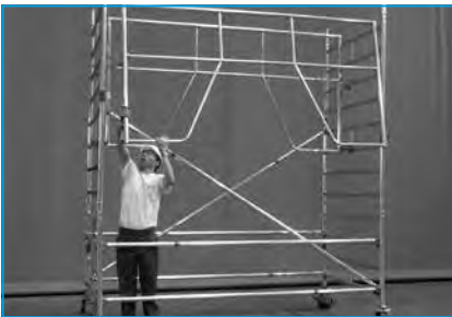
3 - Pose des garde-corps de sécurité définitifs.
