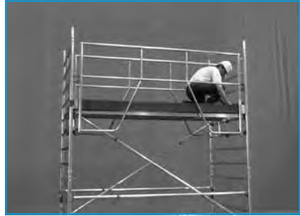
4 - Pose du plancher à trappe, accès au niveau supérieur et pose des plinthes.
