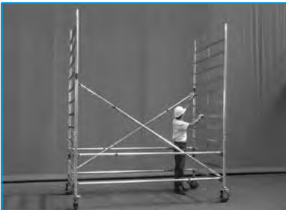
2 - Pose des cadres 8 barreaux puis les diagonales.
