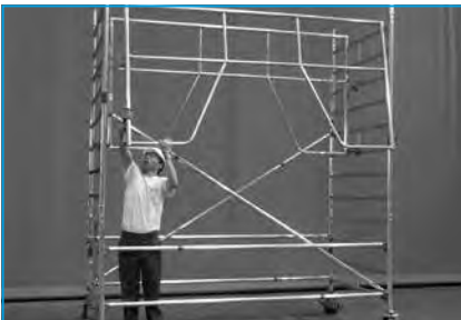
3 - Pose des garde-corps de sécurité définitifs.
